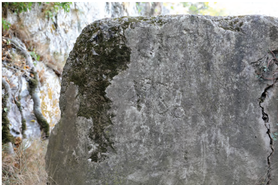
Sl. 61. Urezani natpis 1936 na završetku ogradnog zida terase ispred špilje (snimak: S. Štrkalj, 2022.)
