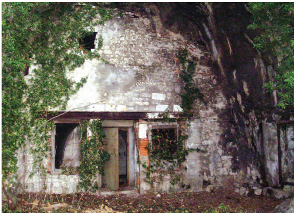
Sl. 55. Pročelni zid crkve s bunkerom (snimak: M. Škugor, 2009.)
