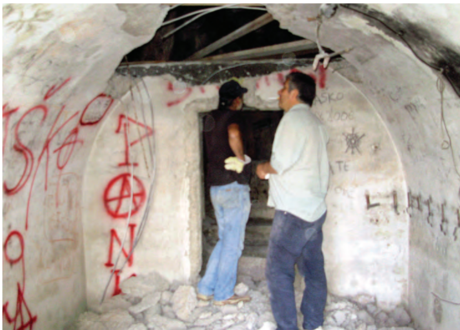
Sl. 58. Rušenje bunkera (snimak: M. Škugor, 2010.)
